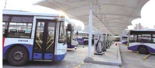
2016年12月15日，浦东周浦公交充电站改造项目正式上电。上海电院电力电子有限公司承接了该工程的全部设备安装、电缆敷设以及充电桩基础相关的场地、沟管工程，历时半年，近日已完成竣工验收。
